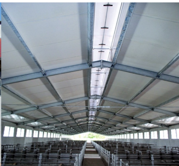
Fot.Nº 6 – Vista de interiores de sala gestación con ventilación natural.
