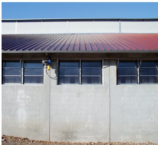
Fot.Nº 5 – Sombbrero longitudinal en vista lateral exterior.
