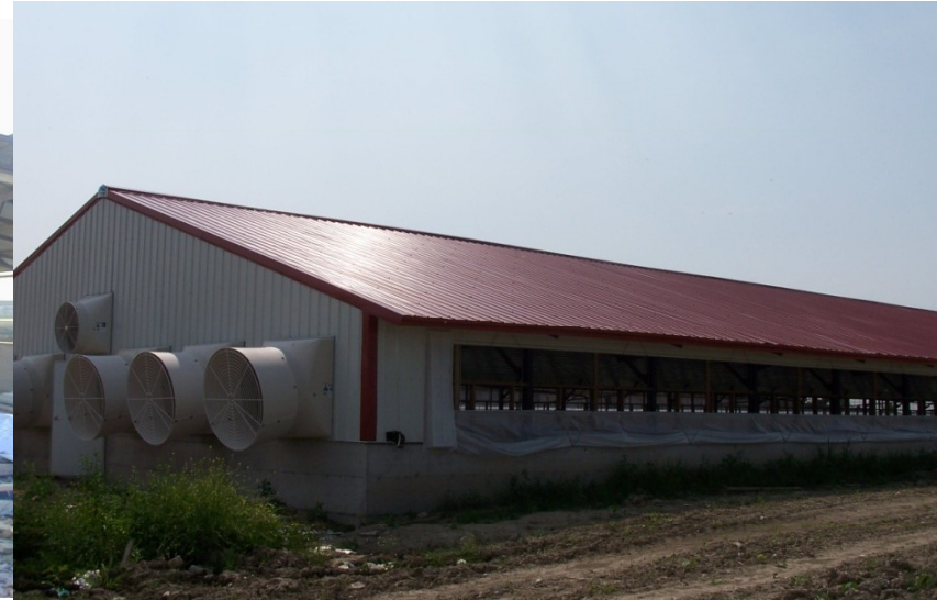
Fot.Nº 2: Vista frontal y lateral de sala de Gestación, con cubierta metálica, extractores de 50" de diámetro y cortinas en PVC a uso manual.
