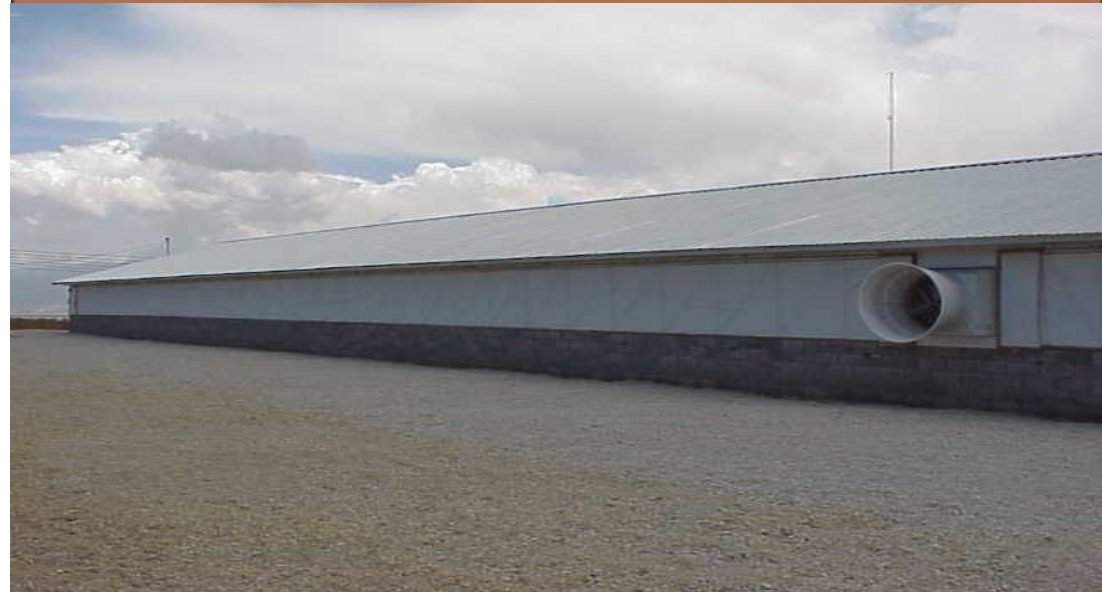
Fot. N°3 – Extractores de 50" de diámetro y cortinas en modo cerrado.
