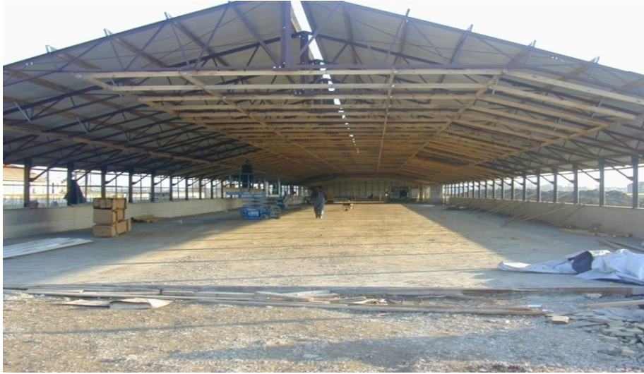
Fot.Nº 1: Estructura y cubierta de techo metálica con tirantes de madera, estructura de sostén de cielorraso con tirantes transversales de madera.
